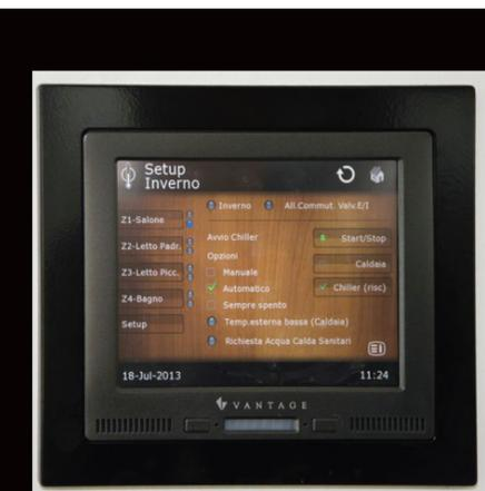
UN TOUCH SCREEN IN-WALL VANTAGE, UNA DELLE INTERFACCE DEL SISTEMA DI AUTOMAZIONE: SUL DISPLAY COMPARE LA SCHERMATA DI CONTROLLO DELL'IMPIANTO COMBINATO CONSOLAR CHE RISCALDA L'ACQUA PER IL RISCALDAMENTO/RAFFRESCAMENTO E PER I SANITARI; È IMPOSTATA LA MODALITÀ DI FUNZIONAMENTO AUTOMATICO.
