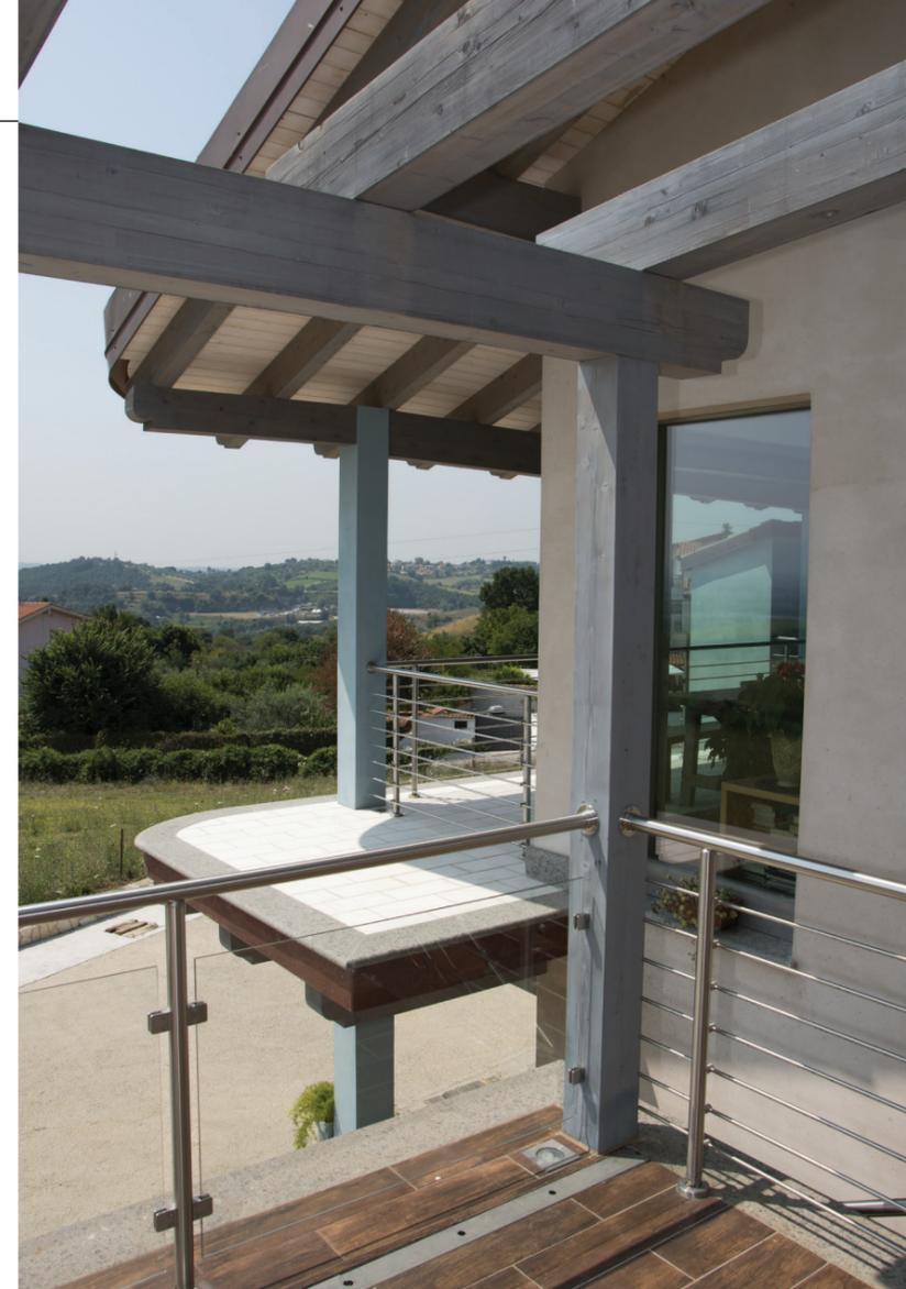
ALCUNI DEI PILONI IN LEGNO CHE COSTITUISCONO LA STRUTTURA PORTANTE DELLA CASA ECOLOGICA DI CAPENA. TALE STRUTTURA POGGIA SU UNA DOPPIA GETTATA DI CEMENTO ARMATO FLOTTANTE SUL TUFO SOTTOSTANTE: NE DERIVA UN'ABITAZIONE PERFETTAMENTE ANTISISMICA, CAPACE DI FLETTERSI SOTTO L'AZIONE DI SCOSSE ANCHE MOLTO FORTI.
